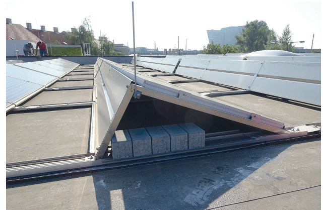
geschlossenes PV-Modul mit Windleitblech
