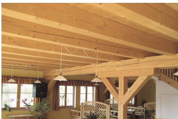
Abbildung 1: Schwindrisse bei Vollholz
