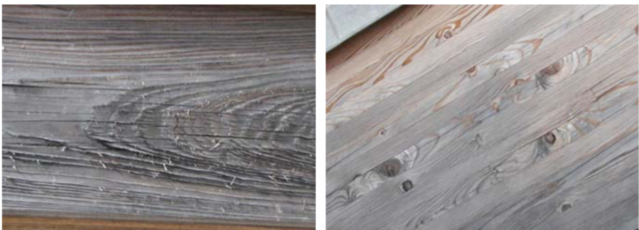
Abb. 5: Risse und Absplitterungen sowie Auswaschungen und Verfärbungen einer BSH-Oberfläche
