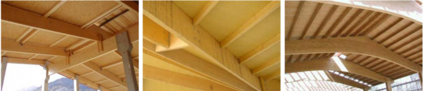
Abb. 1: Beispiele für Tragwerke aus geraden oder gekrümmten Brettschichtholzträgern mit Anschlüssen von Pfetten oder Querträgern; Dachflächenuntersicht aus Holz oder Holzwerkstoffen
