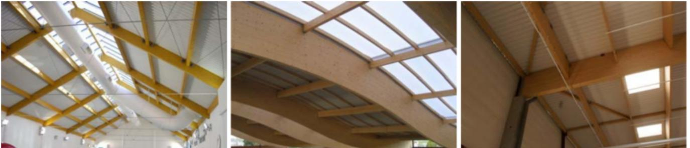
Abb. 2: Beispiele für Tragwerke aus geraden oder gekrümmten Brettschichtholzträgern mit Anschlüssen von Pfetten oder Windverbänden; Dachflächenuntersicht aus Metall (Trapezbleche) sowie Einbauten (Lichtbänder, Oberlichten) und Innenentwässerung
