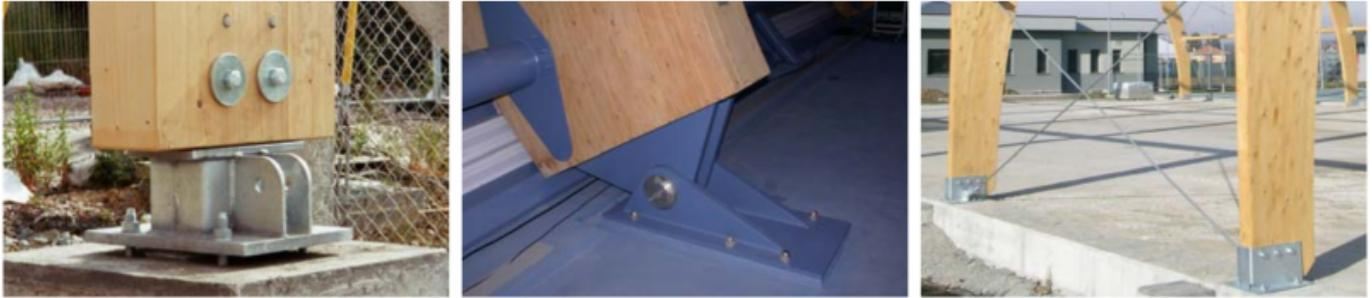
Abb. 5: Fußpunkte aus Stahlteilen für Stützen oder Bogenbinder aus Brettschichtholz
