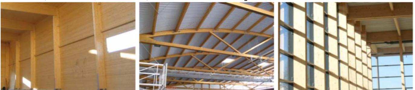
Abb. 3: Wandflächen aus Holz; Tragwerk (gekrümmter Fachwerkträger) mit Trapezblech als Deckung; Fassadenelemente aus Glas
