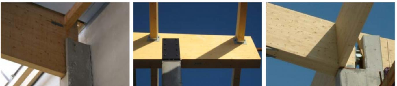
Abb. 4: Gabellager aus Beton und Stahl
