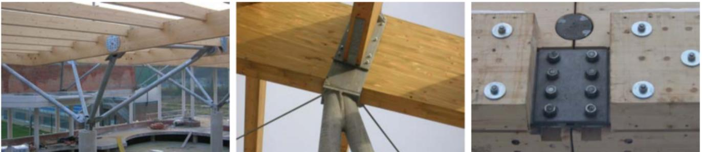
Abb. 6: Druckstreben aus Stahl; Stahlstützen-Anschluss; Knoten mit Stahl-Formteil und Verbindungsmitteln
