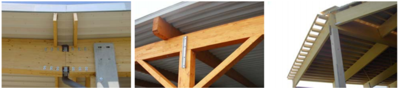
Abb. 10: Randbereiche mit Dachüberstand als Witterungsschutz
